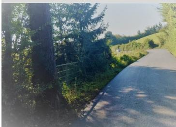
Les travaux sur la route des grenouilles sont terminés. La circulation a été interrompue par tranche, du bas des Engrives jusqu'à la route des fermes. Un reprofilage de la chaussée a été réalisé et de l'enrobé à chaud a été utilisé. Les deux
