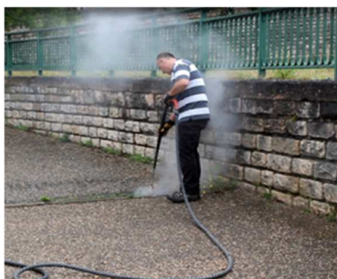
Système eau chaude avec lance d'application reliée à une station sur véhicule
