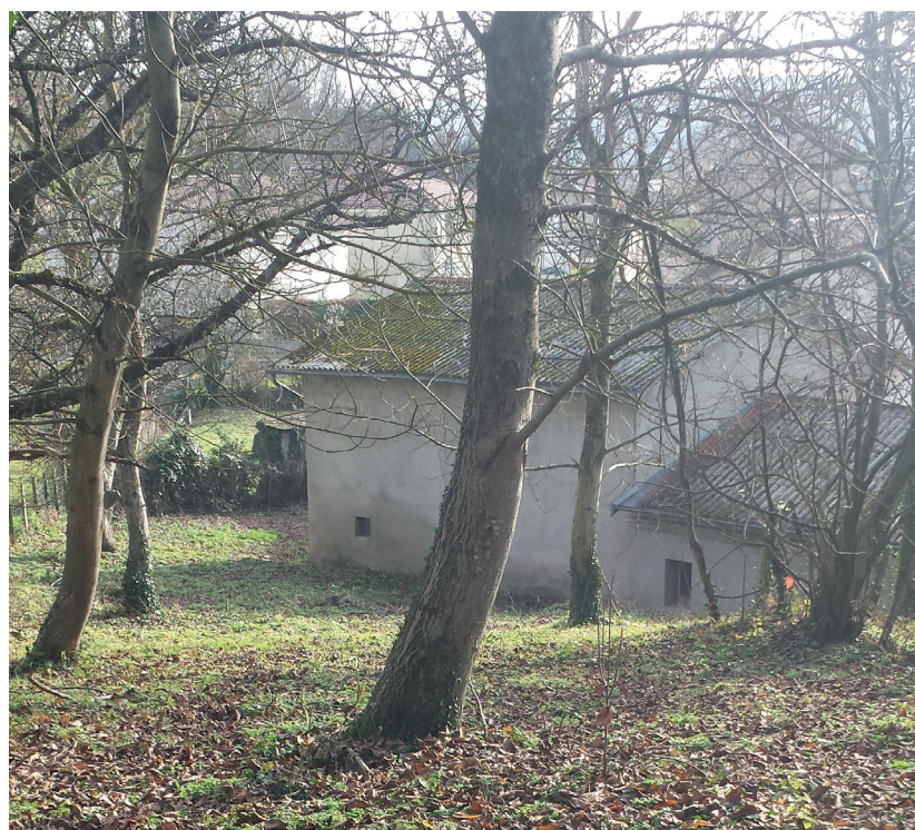
Vue de derrière
